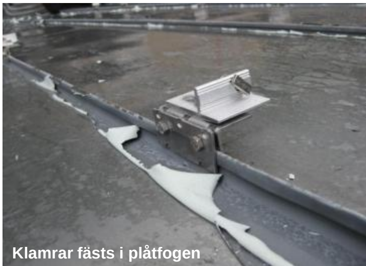
Al-profiler skruvas fast i klamrarna
